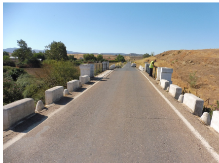
Fotografía 4:paso sobre el arroyo de Las Cigarreras
