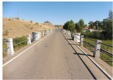
Fotografía 5: paso 1 sobre el río Guadiato
